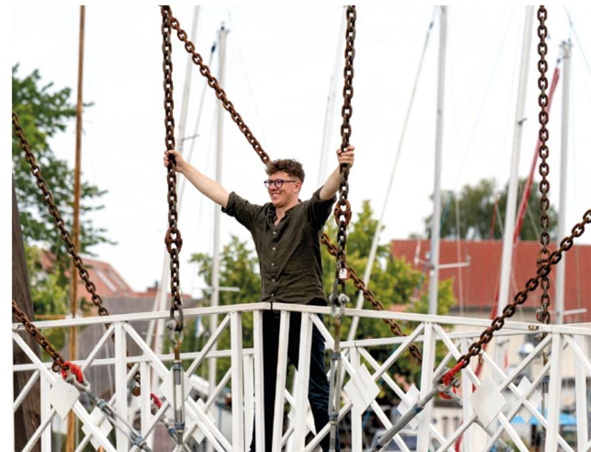
*Hand anlegen: Die nach holländischem Vorbild erbaute Holzklappbrücke in Wieck wird stündlich mit einer Drehkurbel geöffnet*
